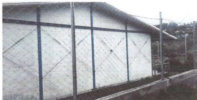
Foto 2: En la Foto se observa la circulación que será sustituida por el nuevo muro de 63 metros cuadrados.
